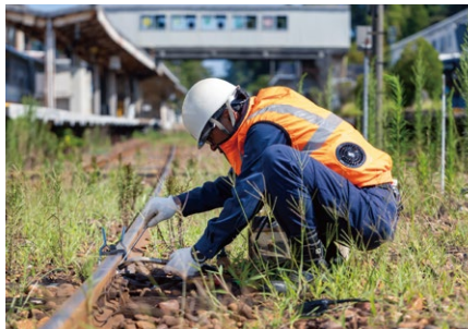
上/のと鉄道では乗務員、信号係、手旗係などを兼務する場合も。少人数制であるため、出発時に事務所内のスタッフへ合図をするなど業務内でのコミュニケーションも大切にしているそう。下/気温が上がると線路が熱を持ち調整が必要に。乗車だけでは気づかない安全点検が日々行われている。
